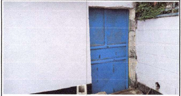
Foto 2. Sustitución de puertas en servicios sanitarios
