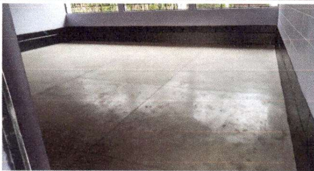
Foto 3. Sustitución de piso de cemento líquido (por piso cerámico)
