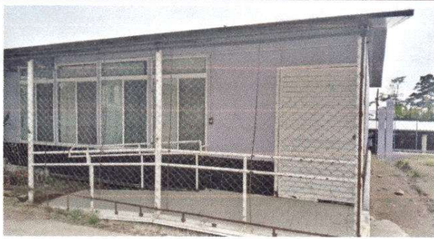
Foto 1. Sustitución de puertas
