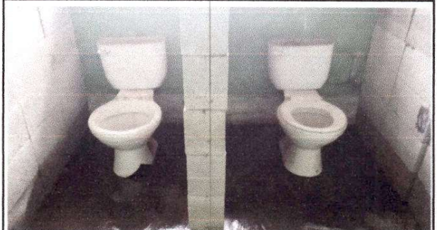
Foto 4. Sustitución de inodoro
